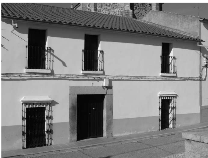
Fig. 8. Fachada de casa tradicional de Medellín.
